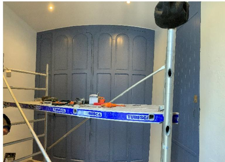
**Réfection sas d'entrée de l'Église** : L'entrée du bâtiment était en mauvais état. Les murs présentaient de la moisissure et le plafond était devenu menaçant. Les travaux, qui ont été totalement réalisés en régie, ont consisté à remettre en état les murs et le plafond pour assurer la sécurité des visiteurs de l'église.
