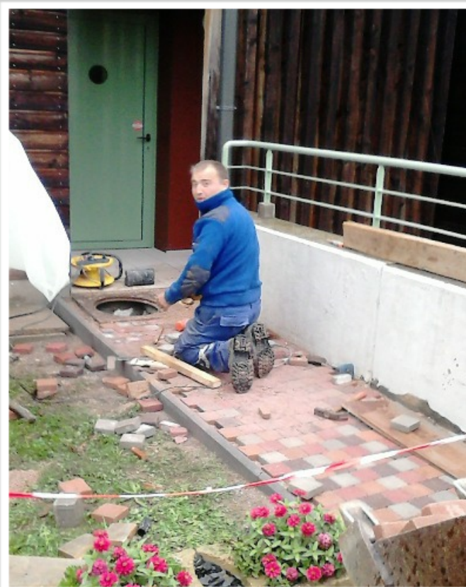
Suite à l'affaissement de l'accès de service de la cantine « espace Saint-Nicolas », le centre technique a procédé à la rénovation de cet accès.
