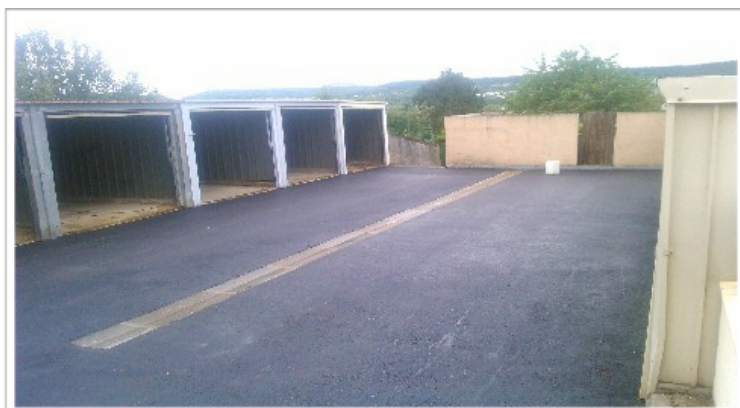
Réaménagement de la placette d'entrées de garages, rue de la Mine.
