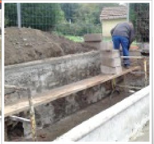
Le Centre Technique Municipal de Bouxières aux Dames, à la demande des élus, a entrepris la rénovation du lavoir des Pâquis. En effet, afin de garantir la sécurité des usagers, il est nécessaire de canaliser l'eau de source coulant sur le sol et le rendant glissant et de réapproprier l'enceinte des murs. Coût de l'opération 5 800 € TTC.
