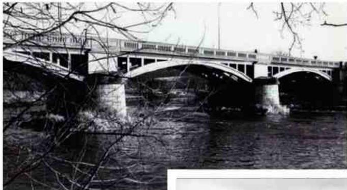
Après guerre, un large tablier en béton a remplacé le passage étroit et en dos d'âne du pont du XVIII<sup>ème</sup>.
