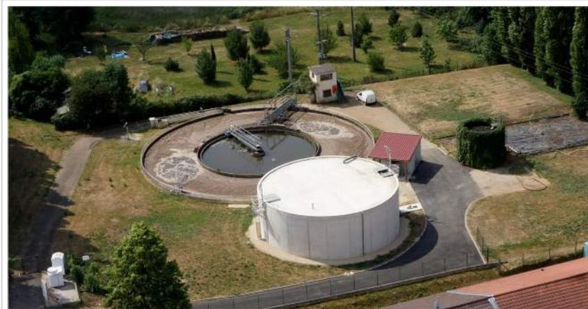
Des travaux ont été réalisés à la station pour une mise en conformité du silo imposée par la Préfecture. Maintenant nous sommes en capacité de stocker les boues pendant une année. La table d'égouttage a été améliorée pour permettre un allègement des boues donc une baisse des prix du transport d'évacuation. Le montant total s'élève à 516 924 € TTC dont en charge à la commune : 264 848 €.
