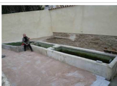
Rénovation du lavoir des Pâquis afin de garantir la sécurité des usagers. Canalisations de l'eau de source, réappropriation de l'enceinte des murs. Coût de l'opération : 5 800 €.
