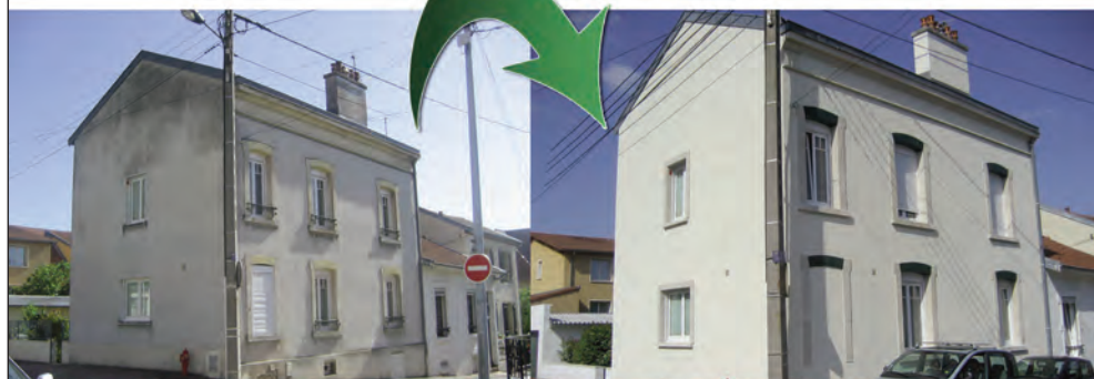
MAISON AVANT RENOVATION >>>>>>> MAISON APRES RENOVATION
