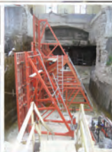
Genie civil pour turbine de production électrique
