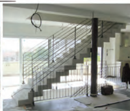
Escalier beton apparent
